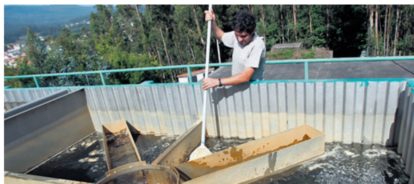
La vigilancia de la ETAP de Caldas es continua para evitar que los filtros se atasquen por el alga. CAPOTILLO
