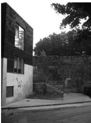
12. Actuales escaleras de unión del Puente Mayor. (Foto Aser)
